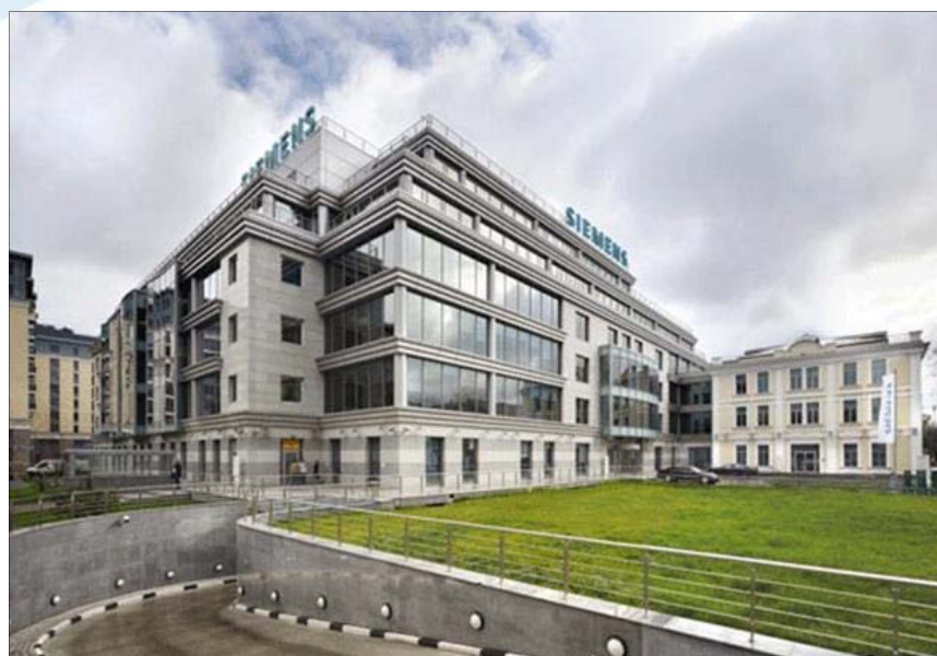
Штаб-квартира компании «Сименс» в Москве (LEED «Золотой»)
