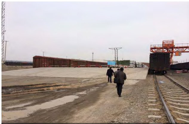
欧州向け列車のコンテナ積替え現場
