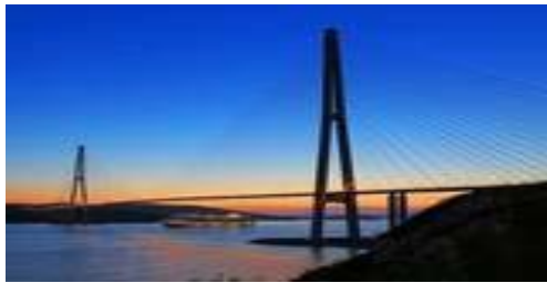
ルースキー島への橋。長さ1.8km。橋桁高さ324m。夕映えの光景はロシア10大景観にリストアップされた。
