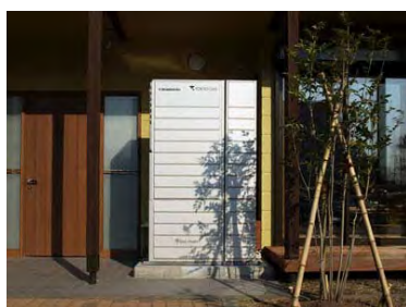
Tokyo Gas 「ENE・FARM」 fuel cell for practical home use
