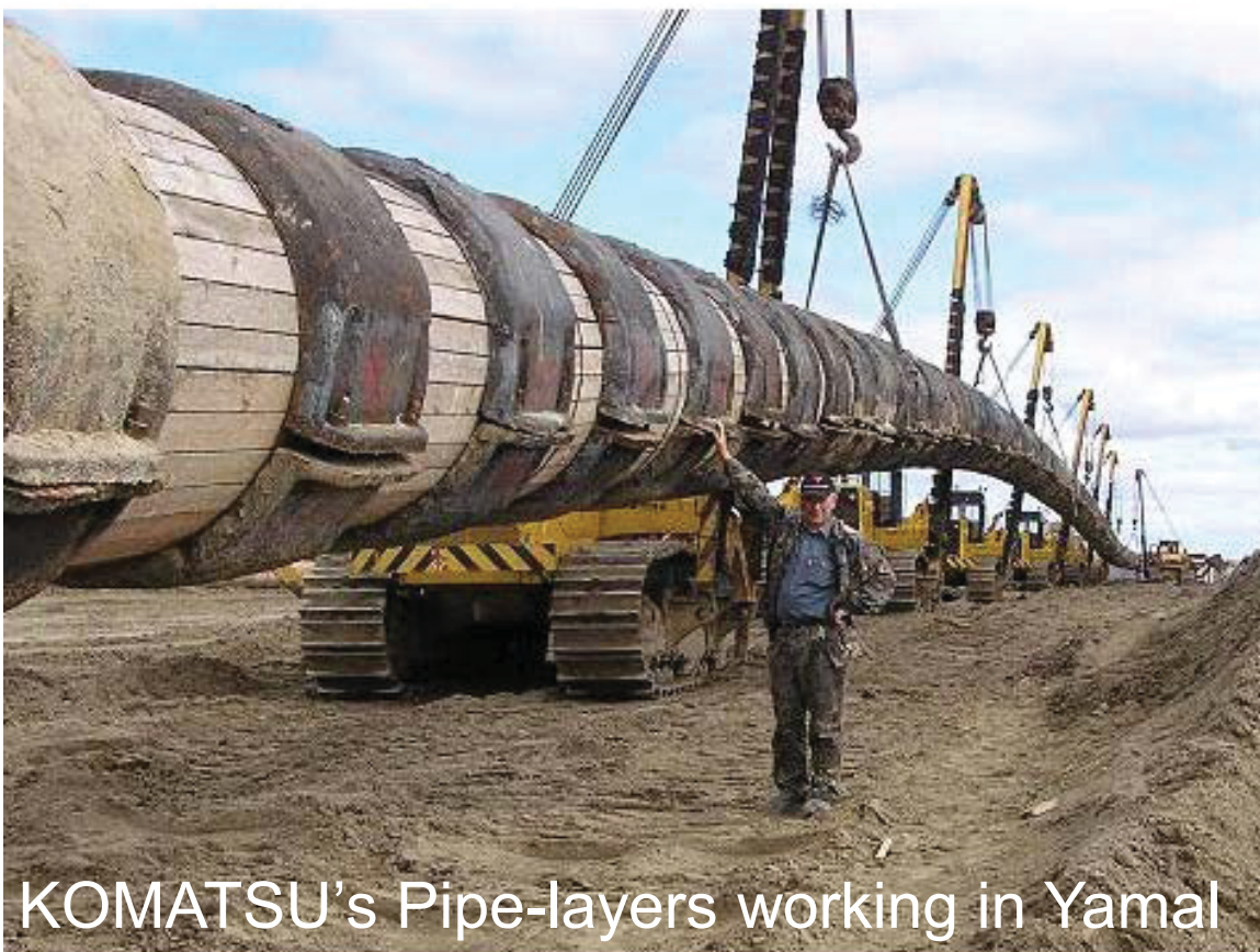
[ヤマル半島のガスパイプライン敷設工事で活躍するパイプレイヤー「D355C」]
