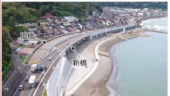
◆一般国道8号弁天大橋の橋梁架替の状況 (新潟県糸魚川市)
