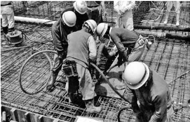
まだ固まらないコンクリートを型枠の中に流し込み、締め固めて一体化を図る（RC建物・精魂込めて施工する作業員）。
