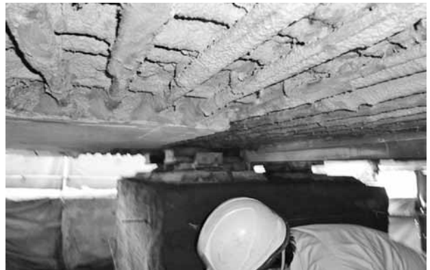
劣化周辺部のコンクリートを取り除き、鉄筋の錆びを落とした上で特殊な補修材で覆い延命策を図る(塩害の補修事例)。
